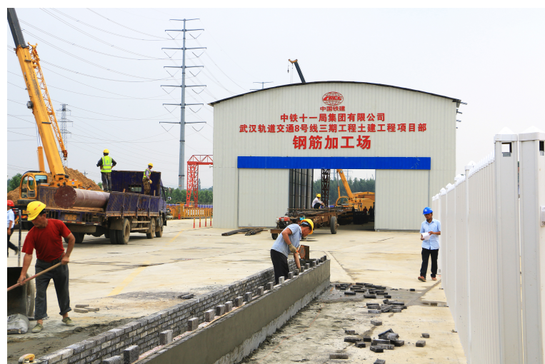
武汉地铁8号线三期工程黄家湖地铁小镇站施工现场
